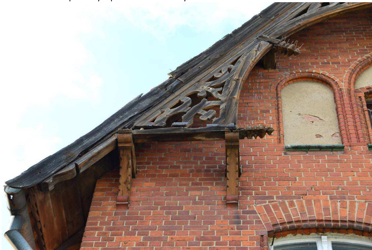
Fot.7 – Detal zwieńczenia szczytu – widoczna uszkodzone belki (pazdury) oraz uszkodzona dekoracja laubzekinowa. Na pierwszym planie uszkodzona rynna.
