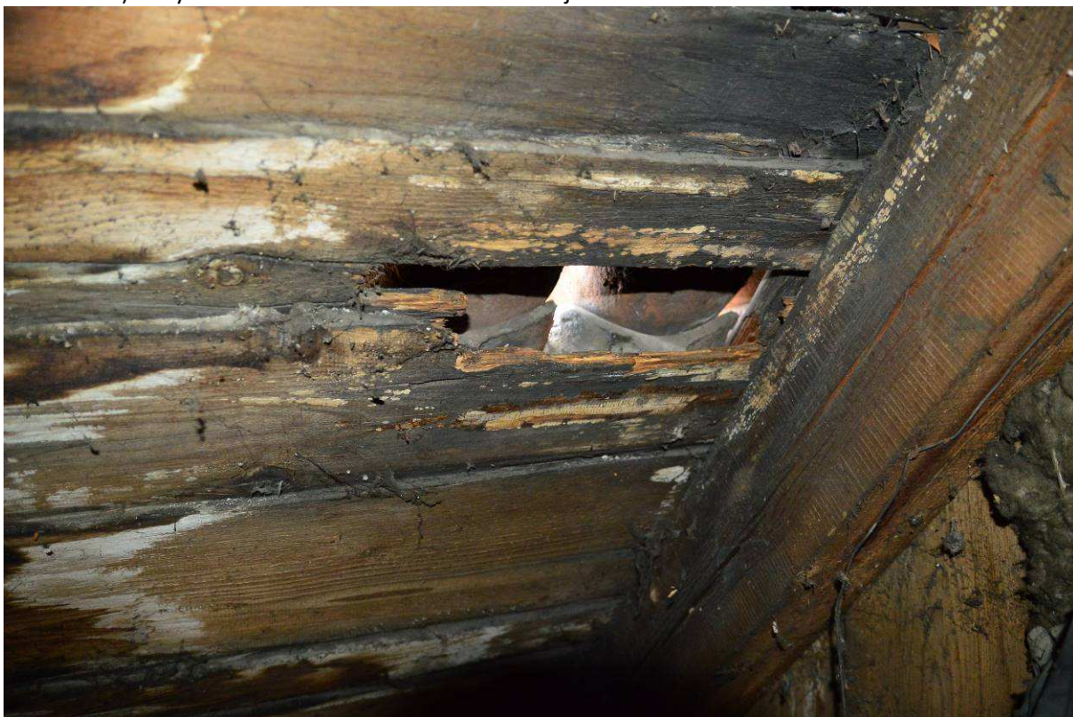
Fot. 5 Deskowanie połaci i krokiew – widoczne uszkodzenie deskowania (zagrzybienie i zbutwienie) i ubytki w deskowaniu. Brak wiatroizolacji.
