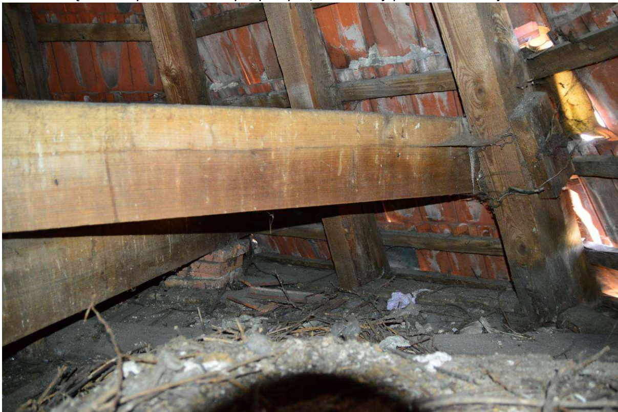
Fot. 4 – Wnętrze wieży – widoczne ubytki pokrycia, brak izolacji przeciwwiatrowej
